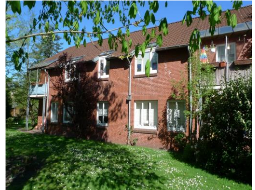
Wohnanlage Westerstede bei Oldenburg 14 WE
