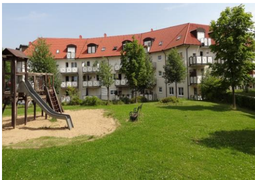
Wohnanlage Meißen bei Dresden 24 WE
