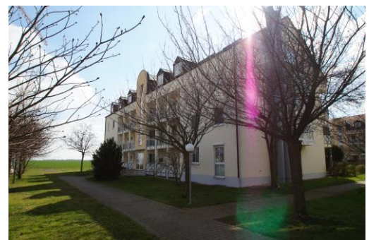
Wohnanlage Leipzig 8 WE
