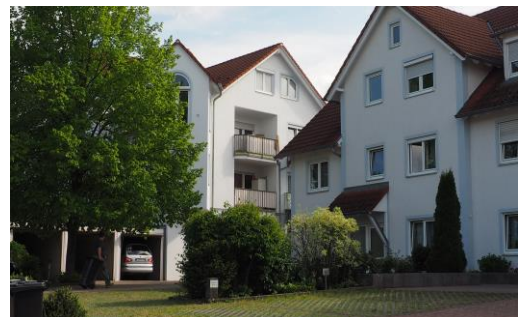
Wohnanlage Pfedelbach bei Öhringen 26 WE
