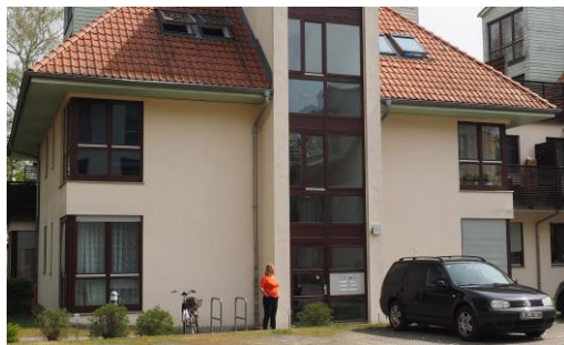
Wohnanlage Eichwalde bei Berlin 14 WE
