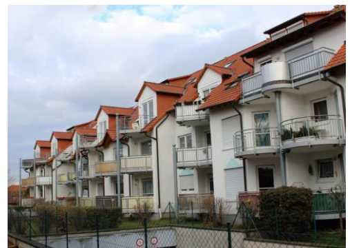
Wohnanlage Erfut 18 WE
