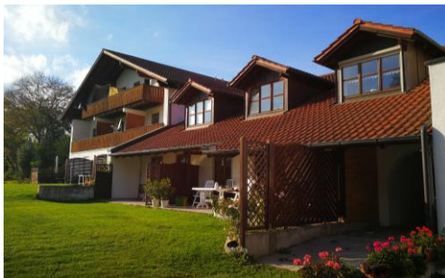
Wohnanlage Marklkofen bei Dingolfing 17 WE
